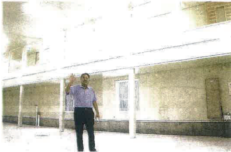
苗場酒造が新たに建設した酒蔵。2階に見学者通路を設けた。津南町下船渡
